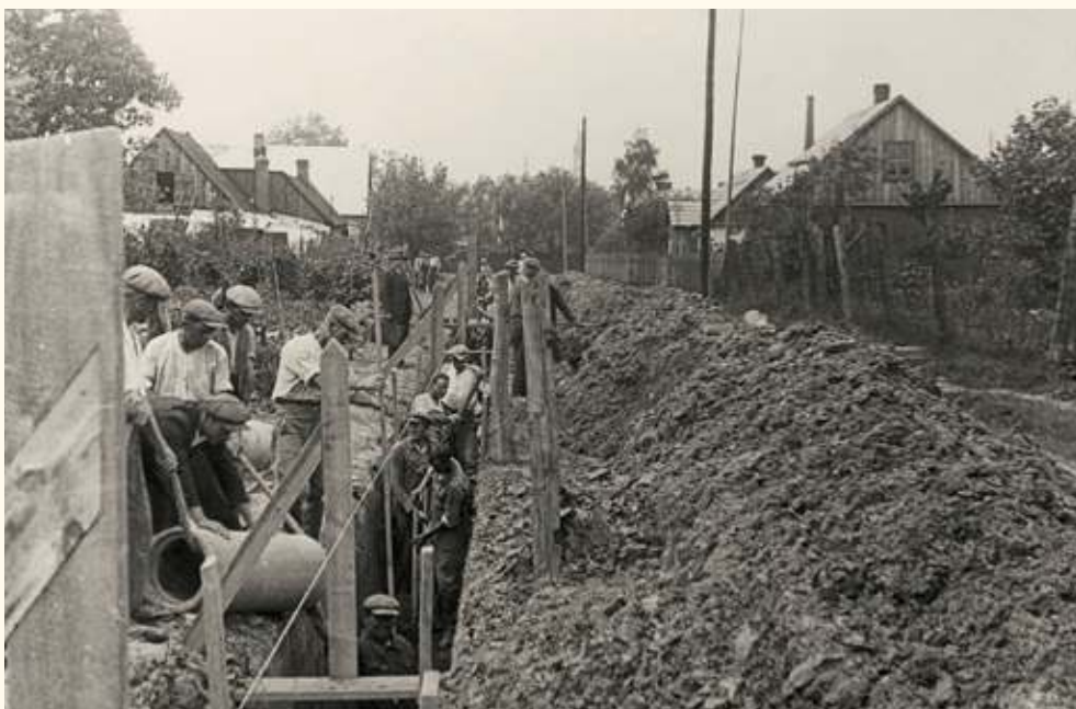
Budowa kanału wód opadowych na Glinicach.
