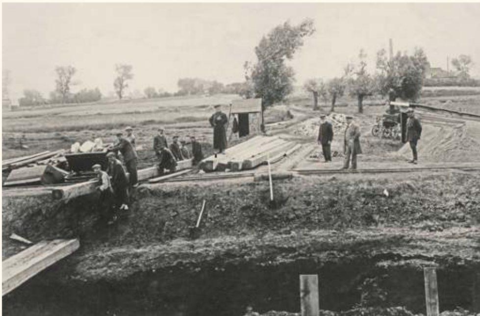
Budowa mostu na Koniówce 1926 r.
