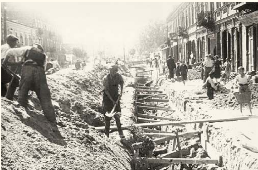
Budowa kanału w ul. Słowackiego.
