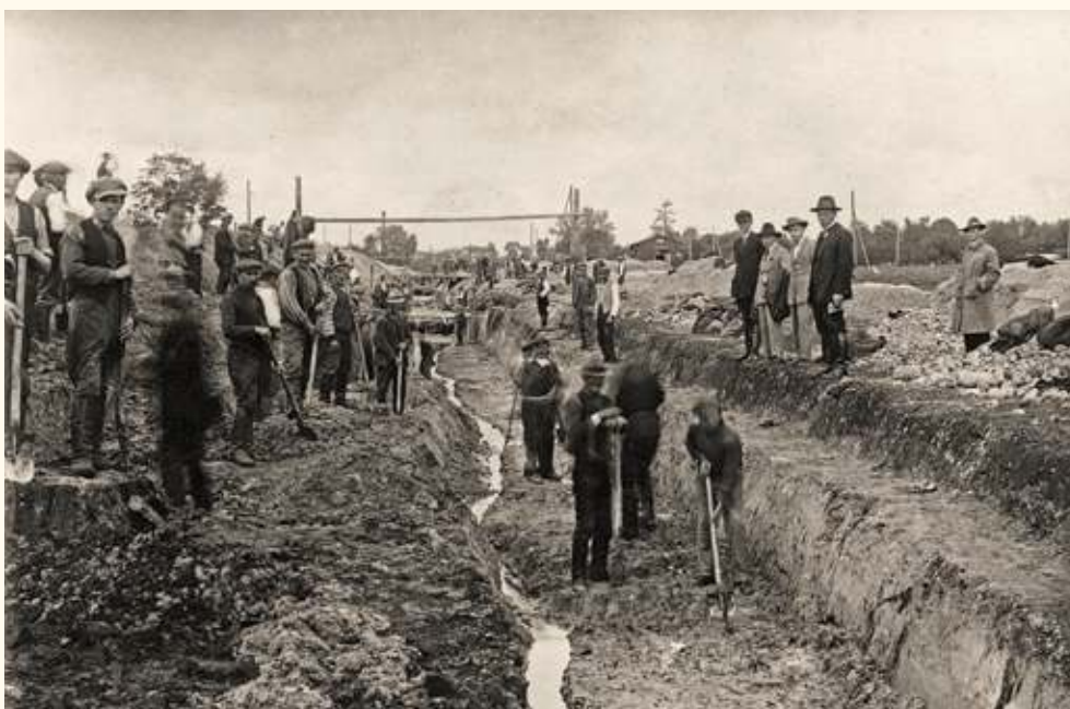
Regulacja i kanalizacja rzeki Mlecznej 1926 r.
