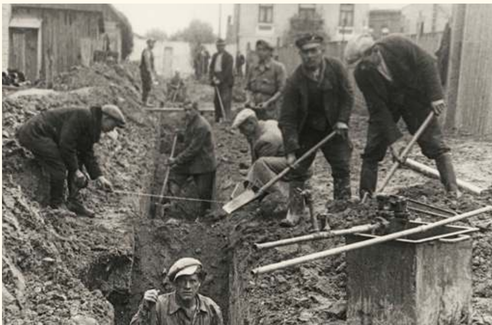
Budowa kanału w ul. Staroopatowskiej 1937/38 r.
