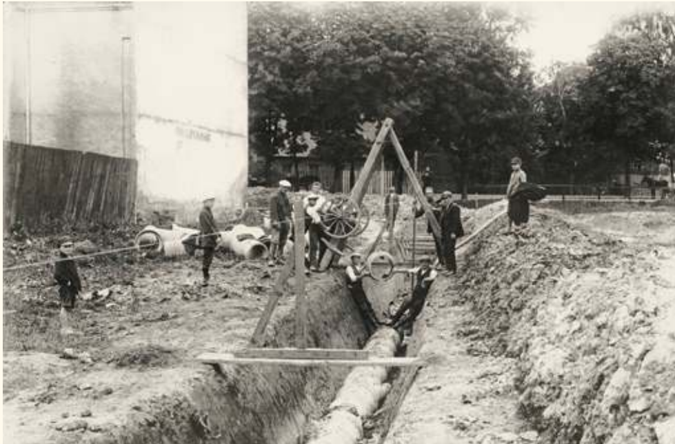
Budowa kanału, ul. Broni 1926 r.
