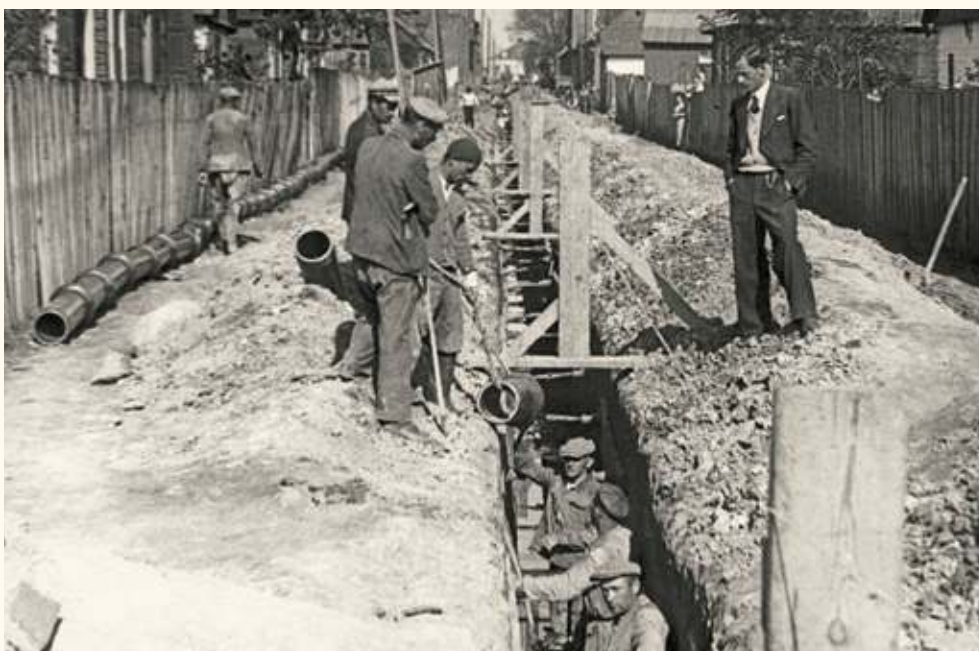
Budowa kanału w ul. Polnej.
