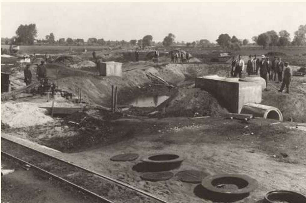
Budowa kanałowego syfonu na Mlecznej 1926 r.
