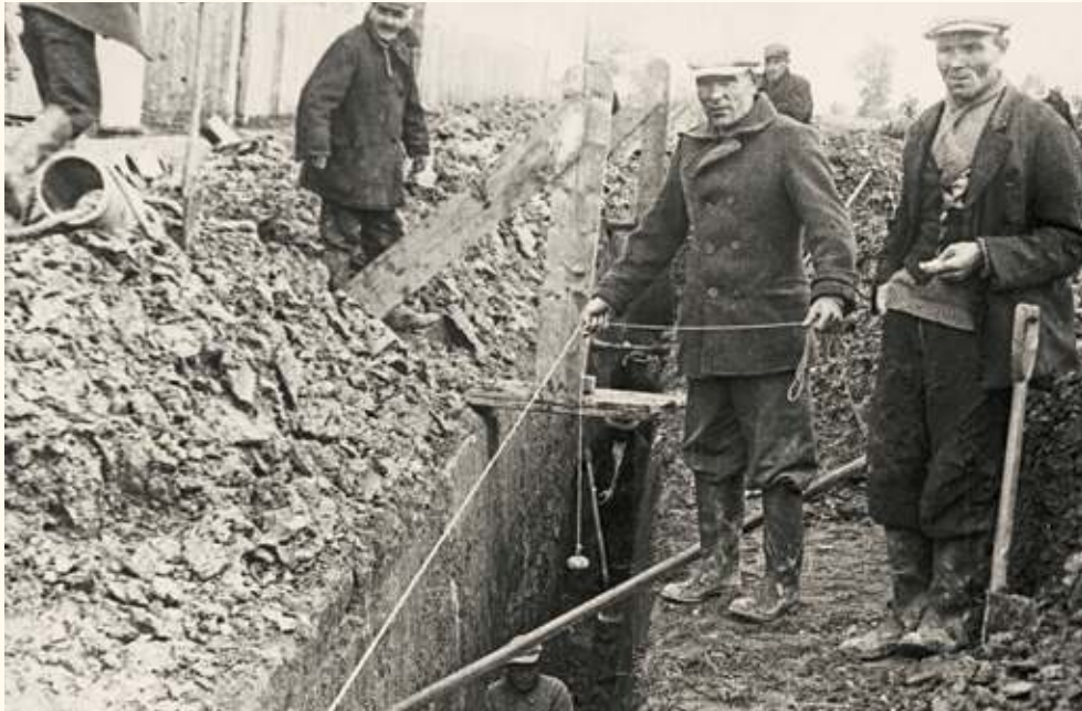
Budowa kanału w ul. Grzybowskiej 1937 r.
