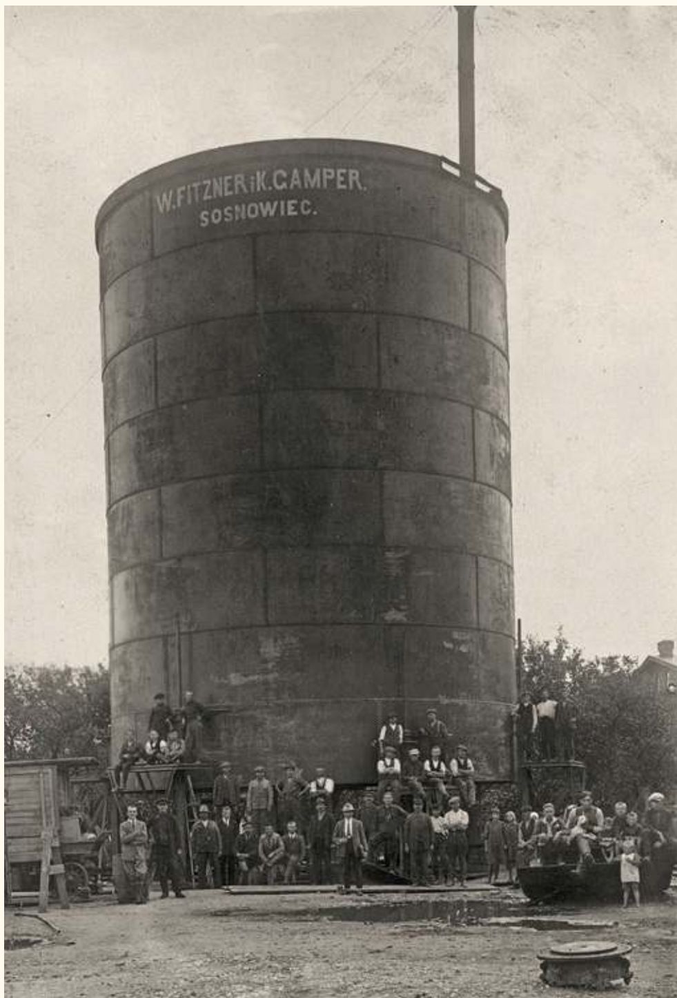
Budowa wieży ciśnien 1926 r.
