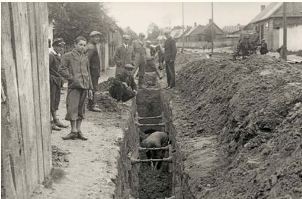
Budowa kanału w ul. Żurawiej.
