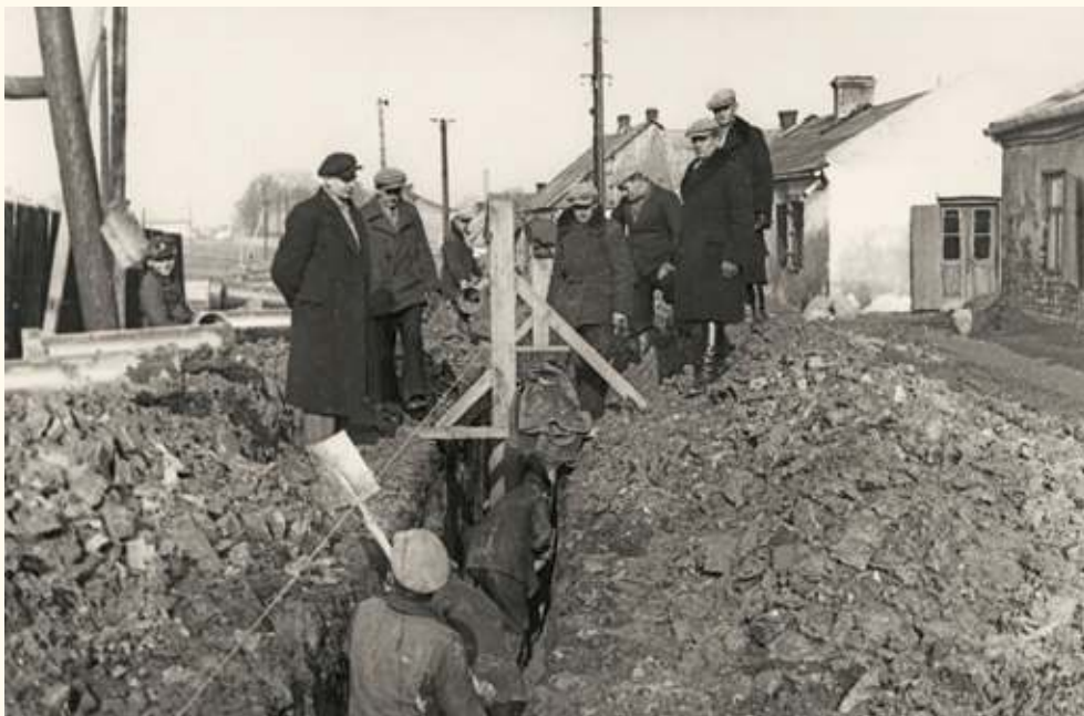
Budowa kanalizacji w ul. Młodzianowskiej 1936/37 r.
