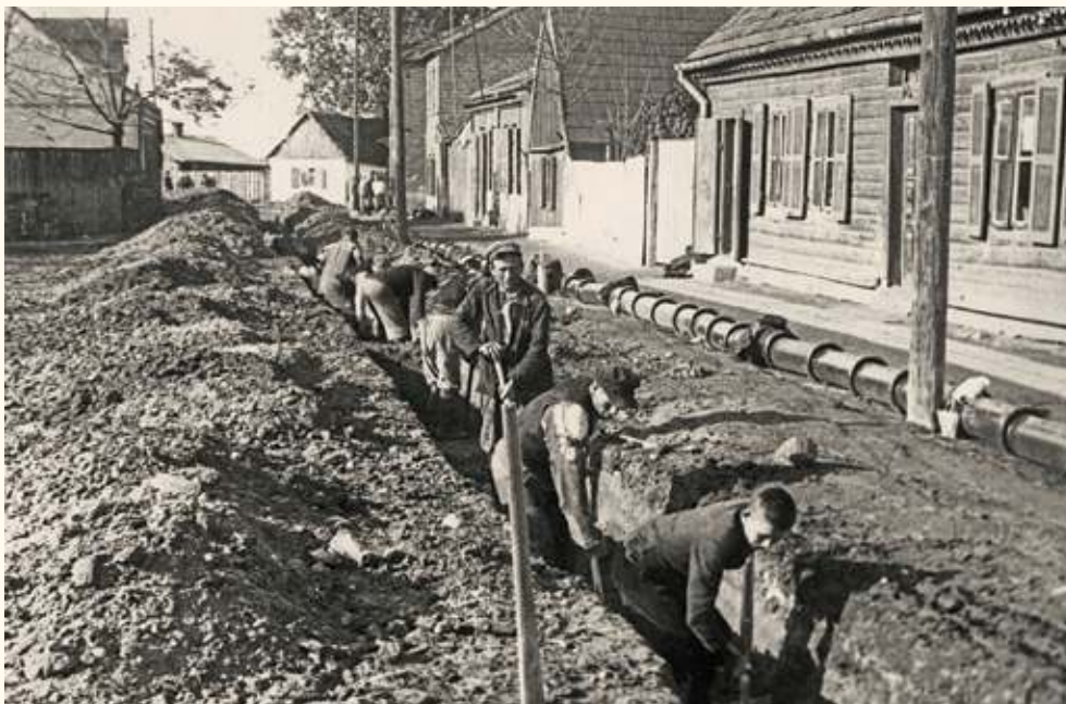
Budowa kanłu sanitarnego w ul. Strzeleckiej.
