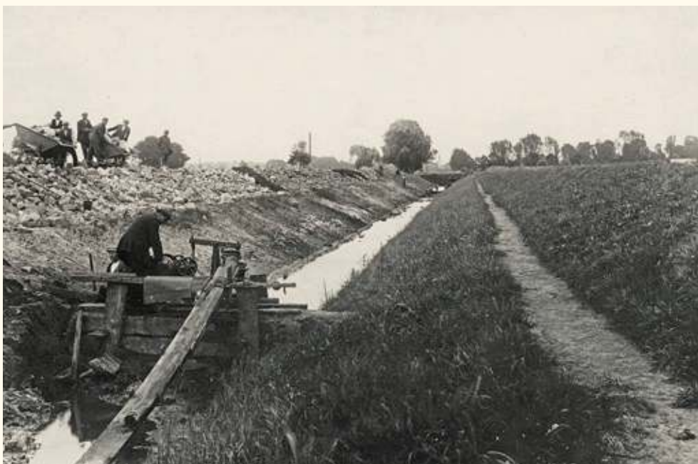
Przekop rzeki Mlecznej na Kamionce 1926 r.
