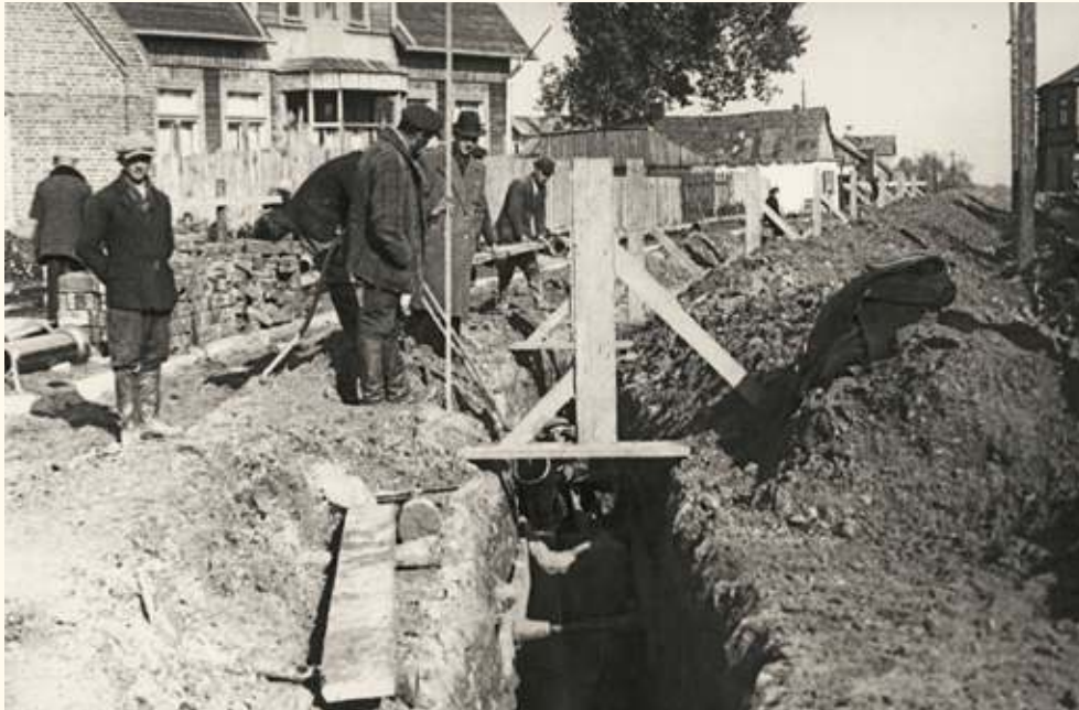
Budowa kanału w ul. Staroopatowskiej 1937/38 r.
