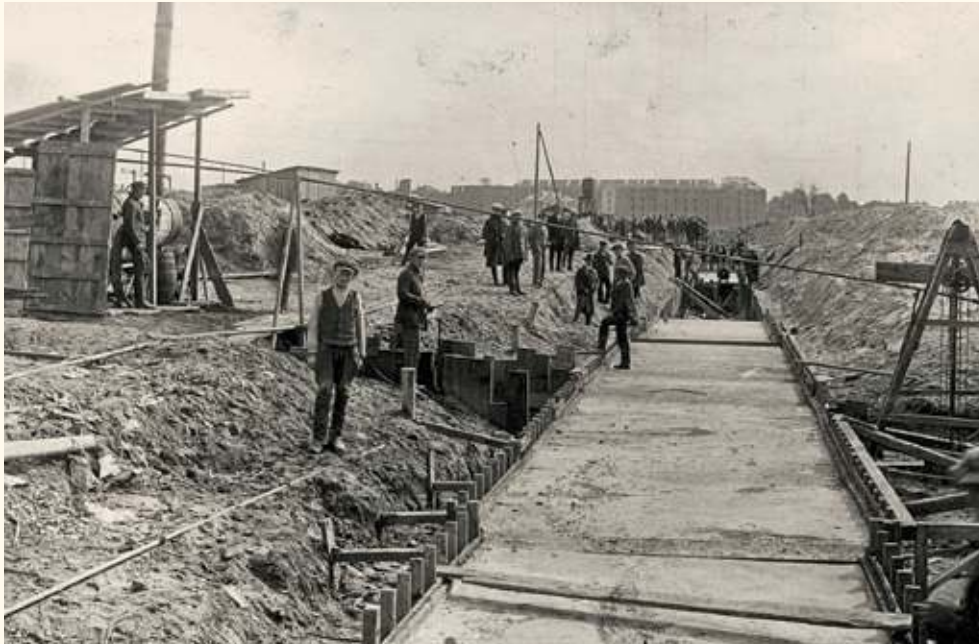
Budowa przesklepienia strumienia Południowego 1926 r.
