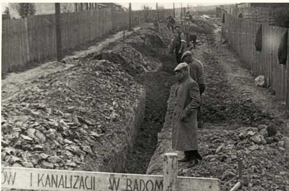
Budowa wodociągu w ul. Katowickiej 1937/38 r.
