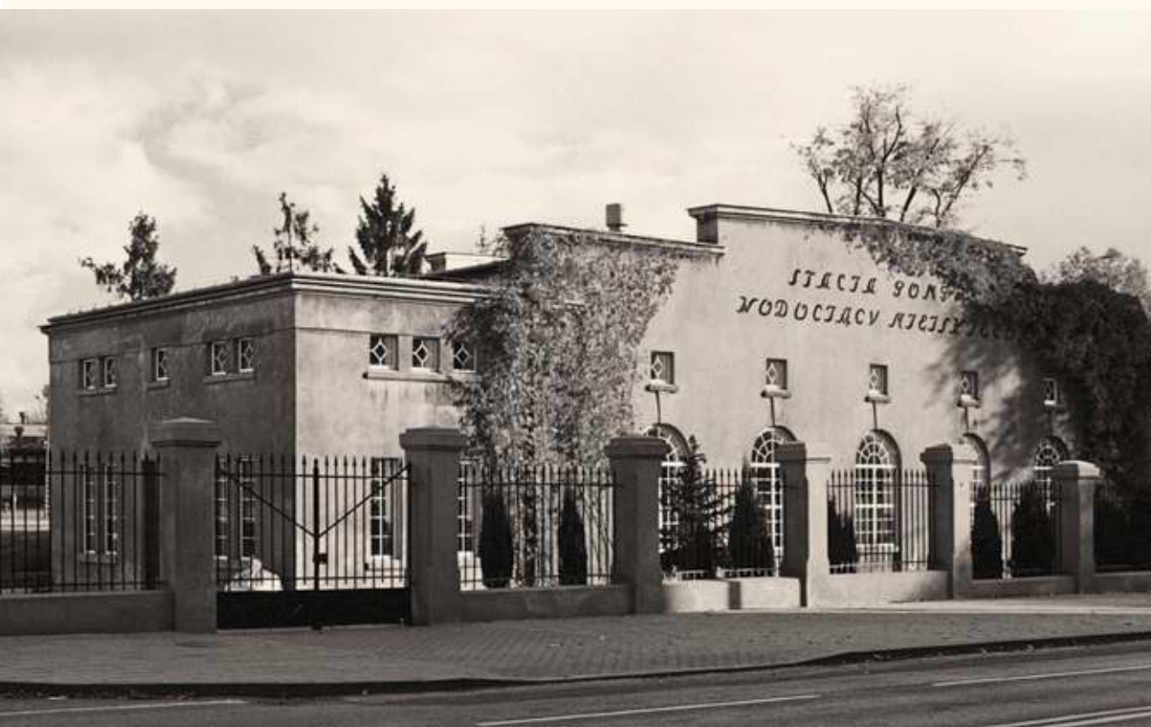
Stacja pomp wodociągów miejskich wybudowana 1926 r.
