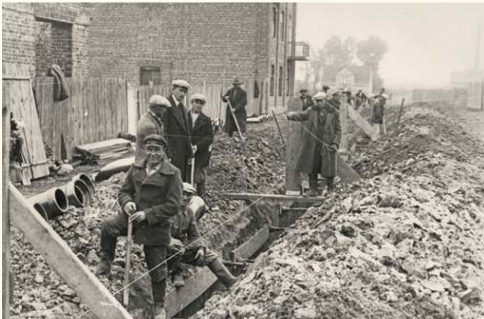
Budowa kanału w ul. Dolnej.
