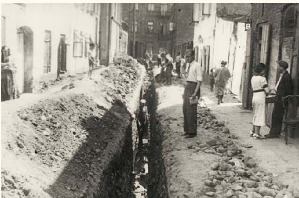
Budowa kanału w ul. Zatyłnej.
