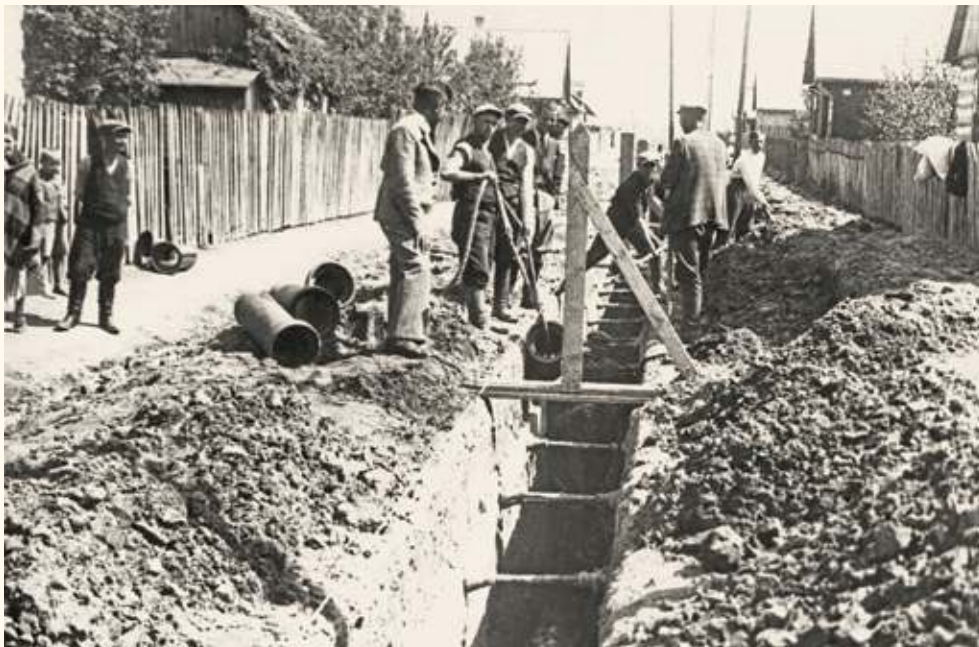
Budowa kanału sanitarnego w ul. Skaryszewskiej.
