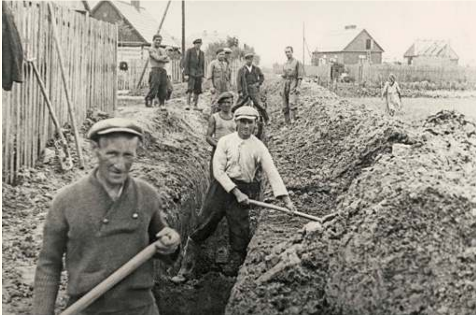
Budowa kanalizacji w ul. Górnej 1936/37 r.
