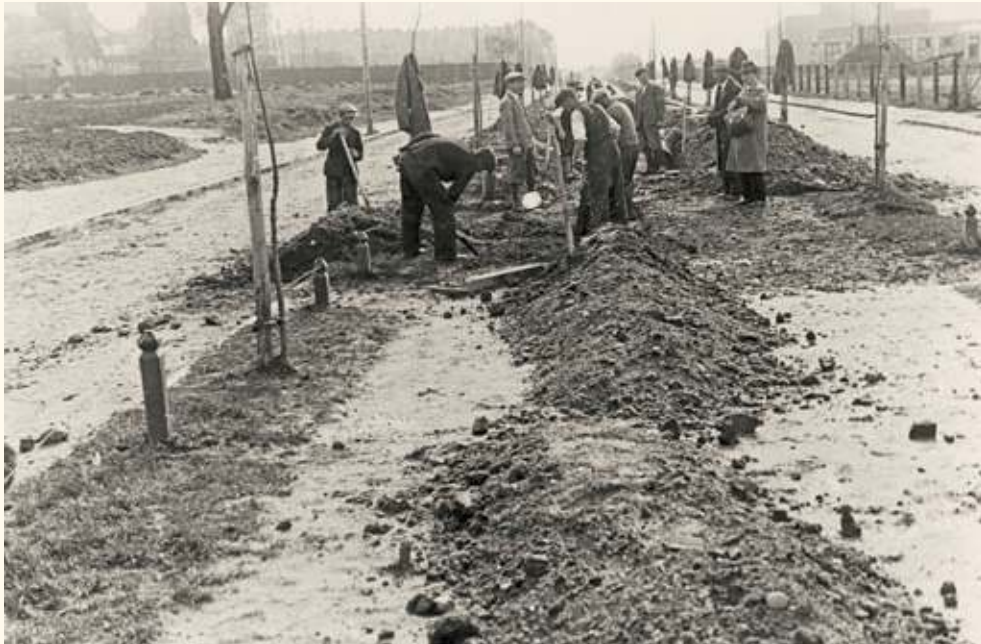
Budowa wodociągu w ul. Narutowicza.
