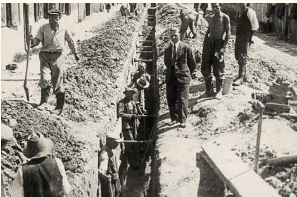
Budowa kanału sanitarnego w ul. Skaryszewskiej obecnie Słowackiego.
